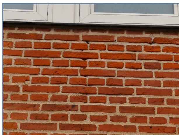
Foto 6: Facade ved badeværelse mod gård
