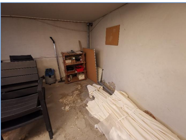
Foto 5: Kabel i viceværtsrum
