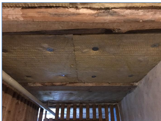
Foto 4: Efterisolering
