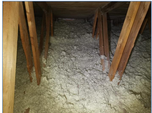
Foto 4: Isolering på loft
