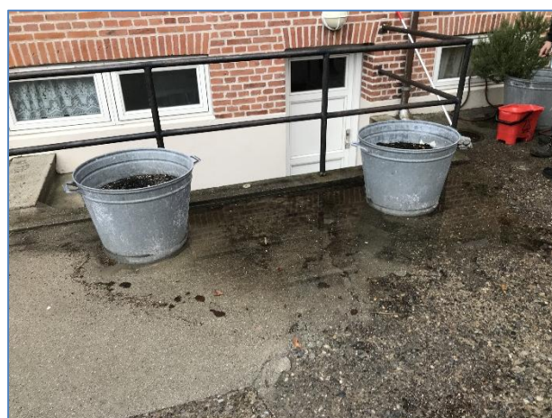
Foto 6: Bagtrappe til kælder
