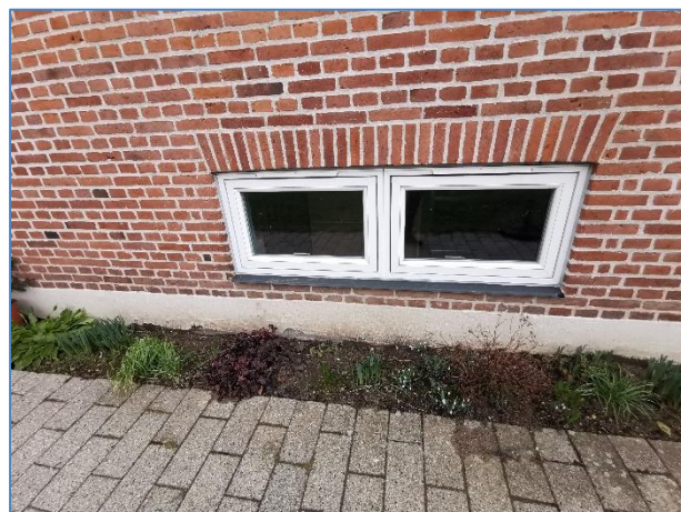
Foto 4: Kældervindue over terræn
