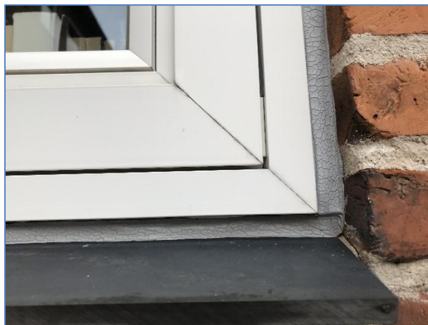
Foto 2: Vindue til bolig
